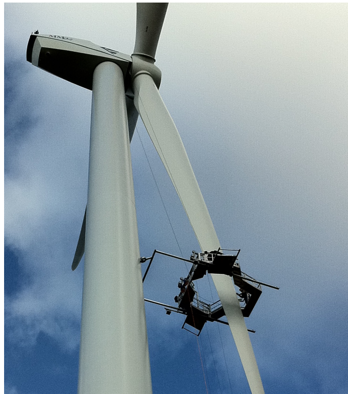
Reparation av ett skadat rotorblad
