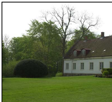
Figur 71. Idegransklotet norr om slottsbyggnaden.
