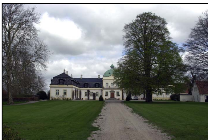
Figur 70. Den obalanserade vyn mot slottsbyggnaden.
