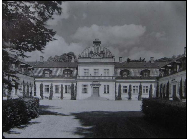
Figur 9. Corps-de-logiet efter ombyggnaden 1906-1908.
